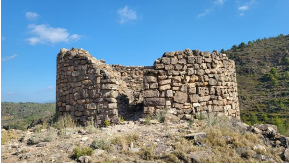
Tower del Mal Paso
